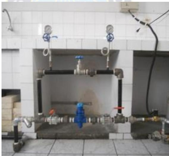
**Figura 23.** Foto del puente de regulación de presión, en la Carrera de Química Industrial.
