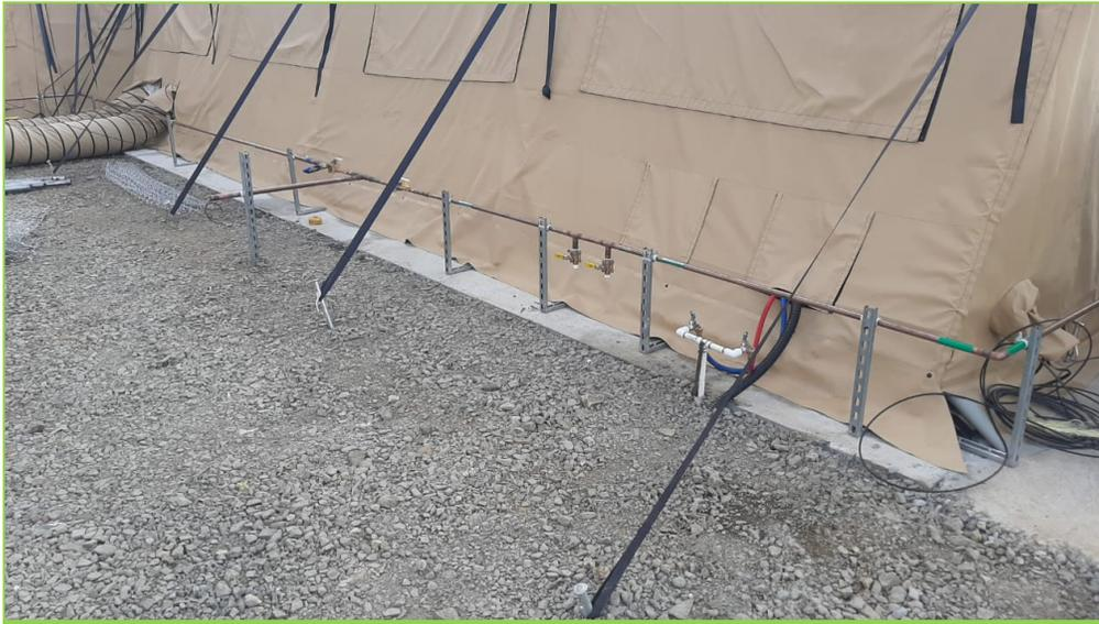
Imagen 3: Conducción de oxígeno en cobre en exterior de tienda de campaña. Las tuberías están marcadas en verde, amarradas con perfiles metálicos, elevadas del suelo y entre los vientos de la tienda para evitar impactos (EMT IRAG CSS Panama).
