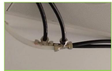
Imagen 4: Imagen de dos líneas de oxígeno en poliamida con derivaciones en T.
