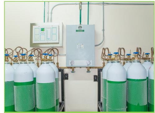
Imagen 7: Grupo de botellas conectadas a través de un manifold.
