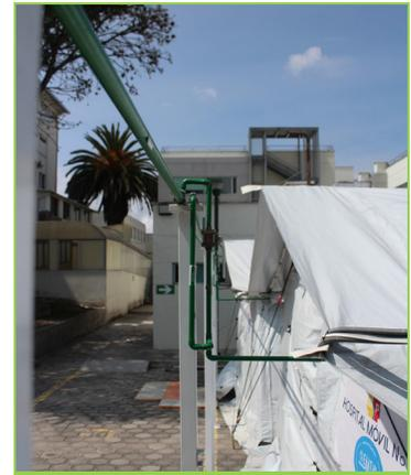
Imagen 1: Fotografía de instalaciones de oxígeno en un EMT IRAG (EMT IRAG MSP Ecuador).
